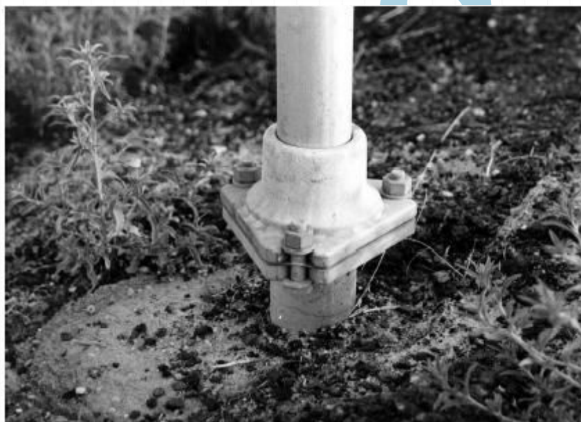
Figura 47 – Base deslizante de um sinal de pequenas dimensões [124].
