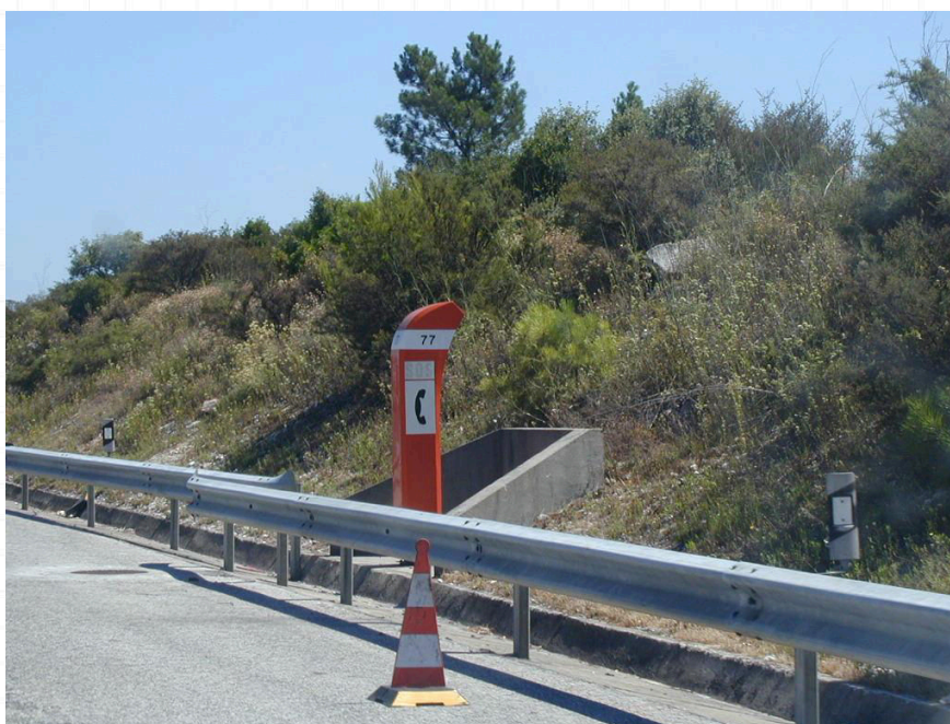
Figura 49 – Cabina telefónica de S.O.S.
