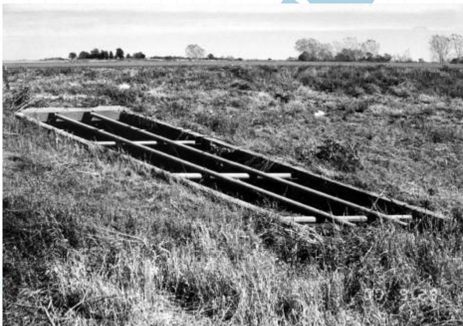
Figura 50 – Boca de aqueduto atravessável [4].
