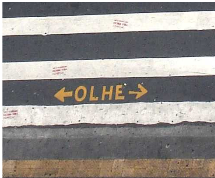
Foto 200: Pintura de solo instruindo o pedestre para olhar em ambos os sentidos antes de atravessar
