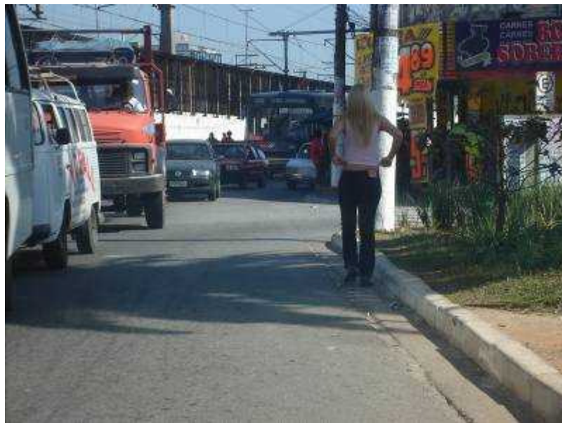
Foto 36: Revestimento inadequado da calçada Foto da autora
