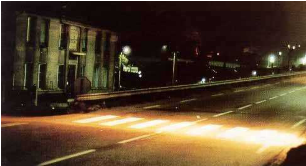
Foto 150:Faixa de travessia de pedestres com iluminação
