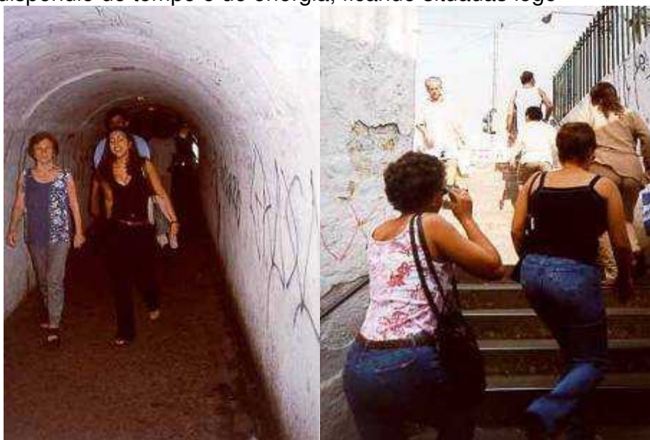
Fotos 173 e 174: Desconforto, aperto e sensação de confinamento na passagem Subterrânea da Estação da Lapa - CPTM.
