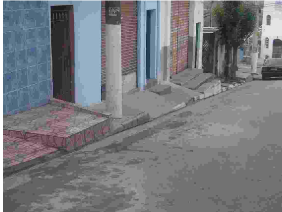
Foto 60 e 61: Mau estado de conservação – buracos e calçada estreita e tomada por degraus e rampas
