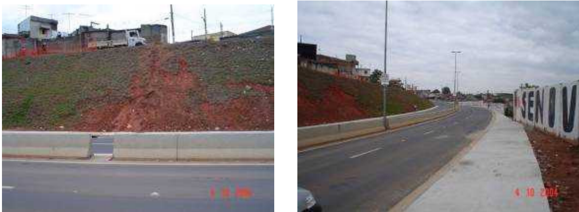
Fotos 143 e 144: Situação de travessia irregular como consequência de um trecho longo de via sem nenhuma travessia sinalizada: a trilha a pé formada no barranco na continuidade da abertura da barreira de concreto – Av. Nova Radial
