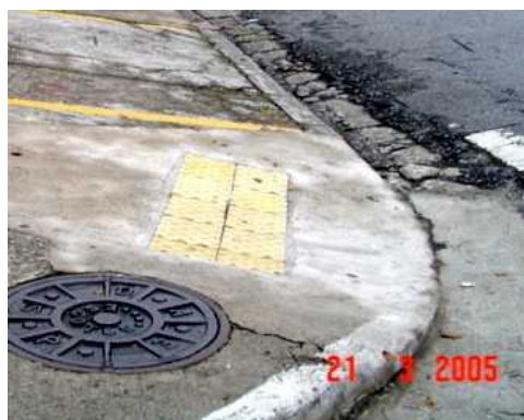
Fotos 180 e 181: Exemplo de rebaixamento de calçada aproveitando rebaixos de guia para acesso veicular pré existente (notar a “adaptação” junto à sarjeta, atrapalhando a drenagem. – Rua Joaquim Antunes
