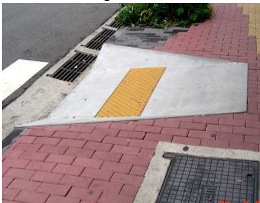
Fotos 178 e 179: Dois exemplos de rebaixamento de calçada corretamente executados. O da esquerda é pré-moldado. – Ruas João Cachoeira e Bráulio Gomes.
