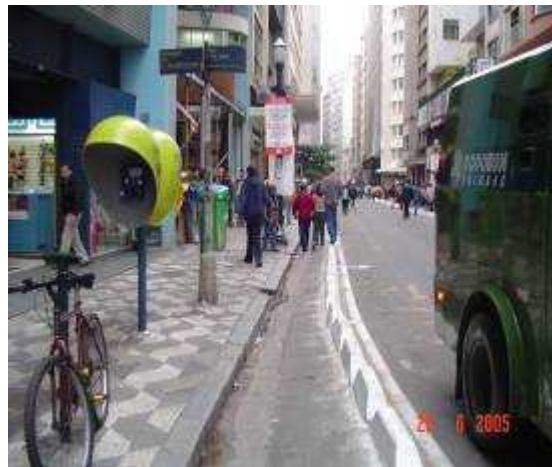
Foto 3: R. 7 de Abril – alargamento de calçada com prismas de concreto –
