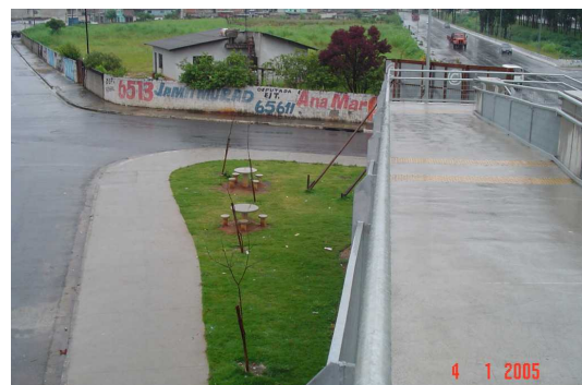
Fotos 169 e 170: Rampas com declividade dentro dos padrões e com superfície anti-derrapante (concreto varrido), dotada de elementos de piso podotátil
