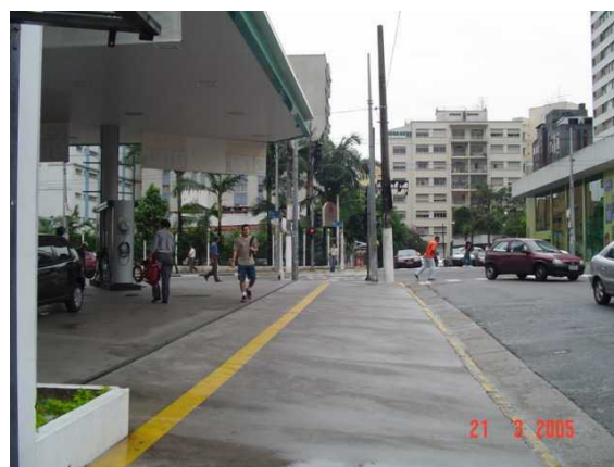
Fotos 182 e 183: Manobra proibida da moto aproveitando o rebaixo de calçada em travessia e extensão total do rebaixamento da calçada em posto de gasolina possibilita o acesso veicular em qualquer ponto da calçada.
