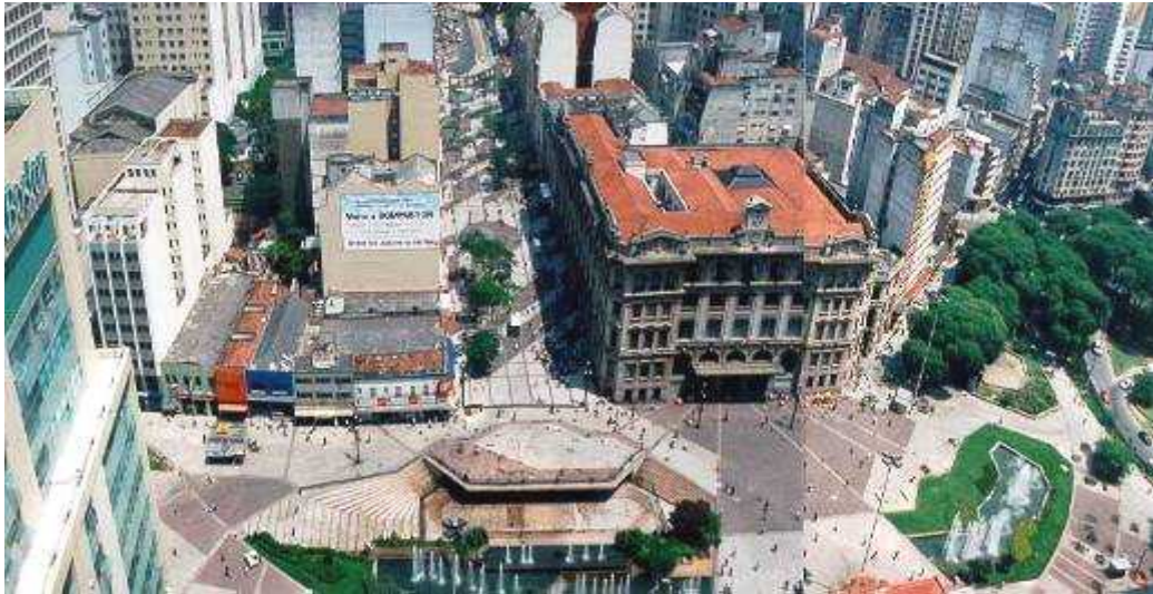
Foto 94: Calçadão do Anhangabaú e da Av. São João – complementação do processo de pedestrianização
