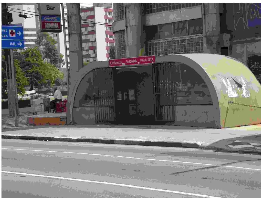
Foto 175: Passagem Subterrânea Av. Paulista X Av. Consolação: ocupada por um sebo e integrada à parada do Corredor Consolação Foto: da autora
