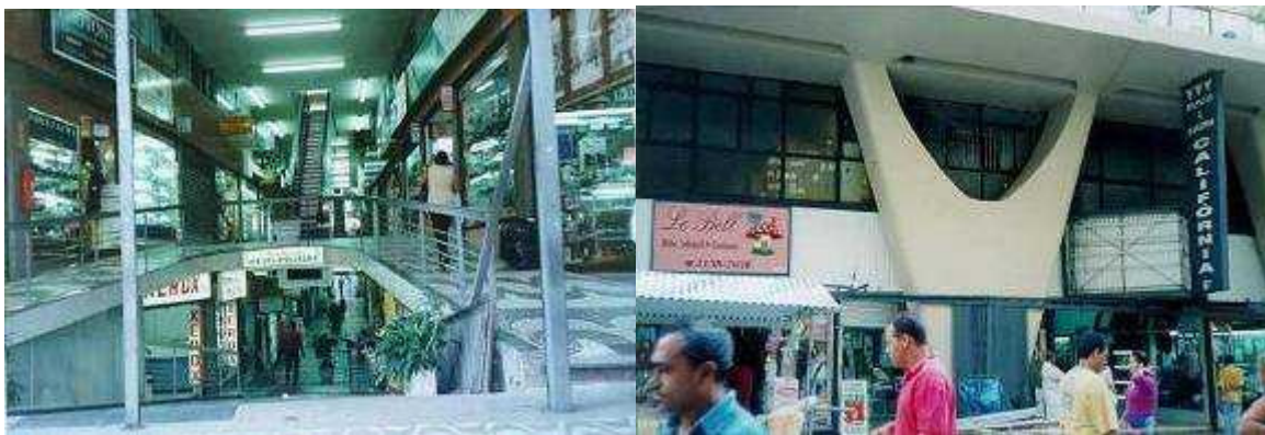
Fotos 43 e 44: Galerias Comerciais do Centro de São Paulo são caminhos atrativos aos pedestres por oferecerem condições de acesso com qualidade, caracterizando um ecossistema urbano na escala da circulação a pé.
