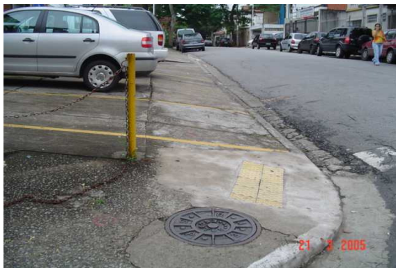
Fotos 180 e 181: Exemplo de rebaixamento de calçada aproveitando rebaixos de guia para acesso veicular pré existente (notar a “adaptação” junto à sarjeta, atrapalhando a drenagem. – Rua Joaquim Antunes
