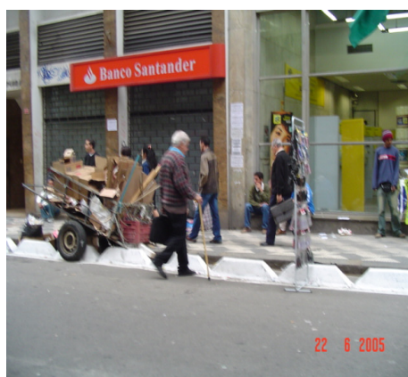
Fotos 84 e 85: Prismas de concreto utilizados como delimitação da ampliação de calçada: Na fase de obras a desconsideração das características do modo de transporte a pé trouxe resultados inadequados. – Rua 7 de Abril Fotos da autora
