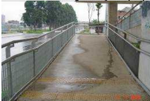
Fotos 169 e 170: Rampas com declividade dentro dos padrões e com superfície anti-derrapante (concreto varrido), dotada de elementos de piso podotátil
