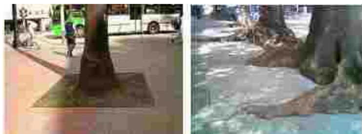
Fotos 210 e 211: A raiz da árvore pode ser integrada ao piso através de elemento vazado ou ficar sufocada pelas tentativas de recuperação do calçamento. R. Cel. Xavier de Toledo e rua de Moema.
