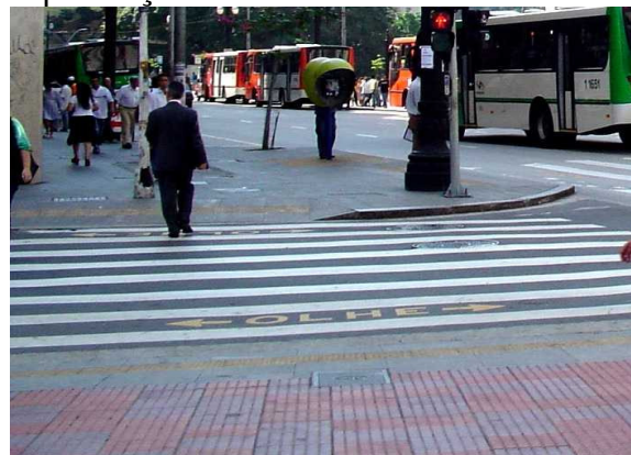
Fotos 178 e 179: Dois exemplos de rebaixamento de calçada corretamente executados. O da esquerda é pré-moldado. – Ruas João Cachoeira e Bráulio Gomes.
