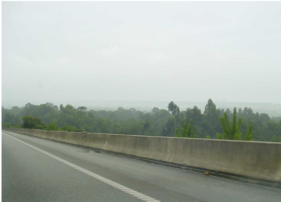
Imagem II. 14 – Barreira “New Jersey” colocada no extremo da plataforma
