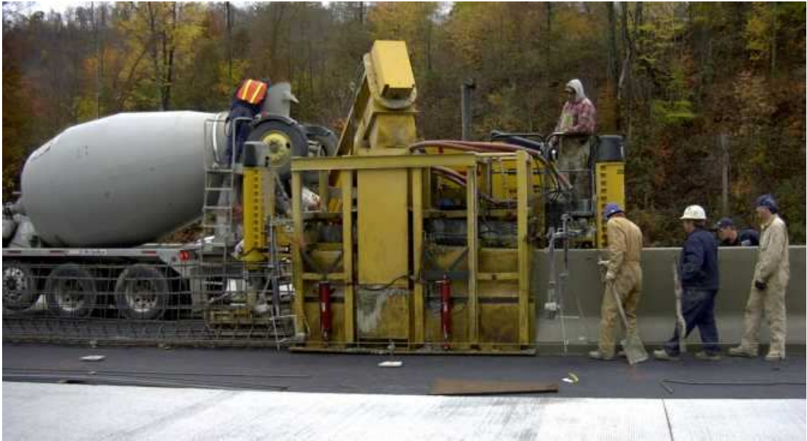
Imagem II. 16 – Execução de barreira de betão tipo New Jersey “ in situ ”
