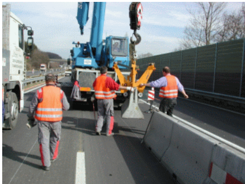
Imagem II. 17 – Colocação de barreiras de betão tipo New Jersey pré-fabricadas
