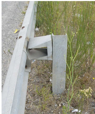
Imagem III. 1 – Pormenor do conjunto: amortecedor/prumo/viga
