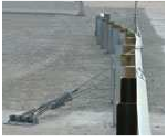
Imagem II. 4 – Transição Barreira Semi-flexível - Flexível
