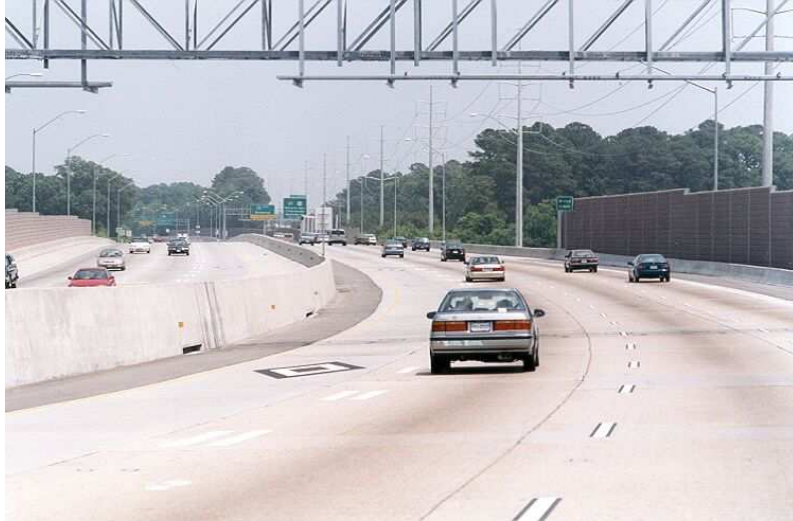
Imagem II. 19 – Barreira rígida em betão com paramento constante
