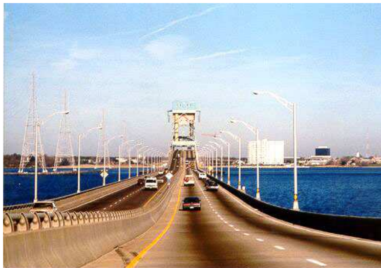
Imagem II. 20 - Barreira rígida em betão tipo GM
