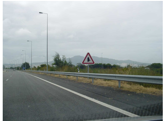
Imagem II. 11 – Perfil em “W” colocado no extremo da plataforma
