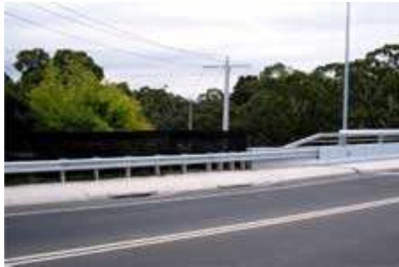
Imagem II. 3 – Transição Barreira Rígida – Semi-flexível
