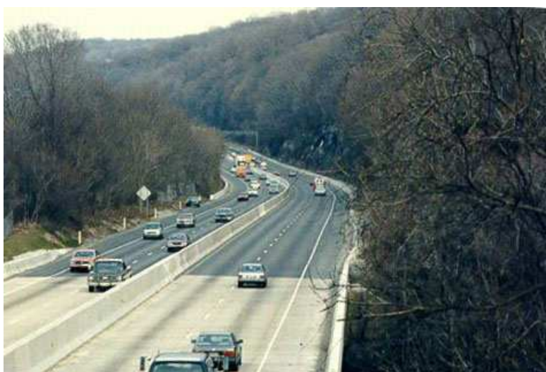
Imagem II. 18 – Barreira rígida de betão com perfil F
