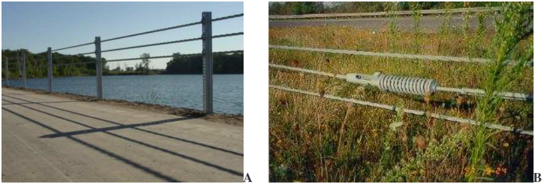
Imagem II. 9 – Barreira flexível de cabo triplo: A- aspecto geral B – pormenor da ligação entre cabos
