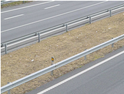
Imagem II. 10 – Perfil em “W” colocado no separador central
