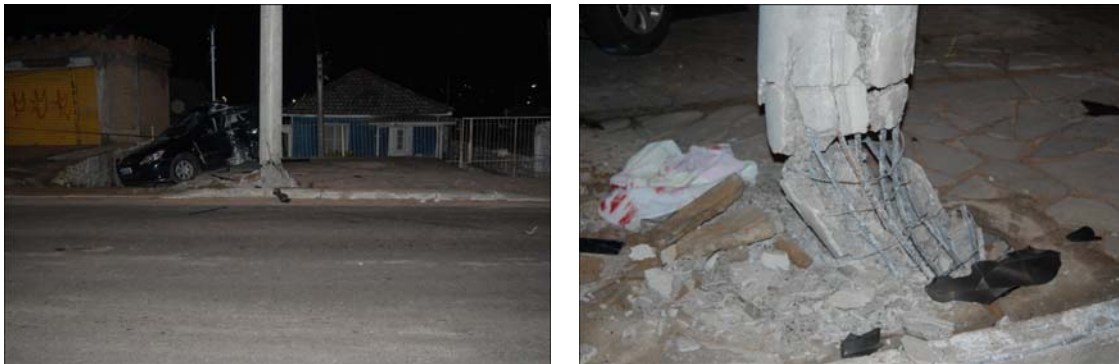
Figura 8. Exemplo da Fase 3 a) imagem geral e b) detalhe da estrutura do poste
