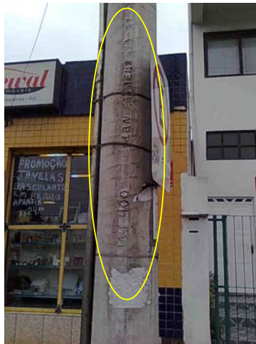
Figura 1. Exemplo de identificação em baixo relevo em poste de concreto (destaque em amarelo).
