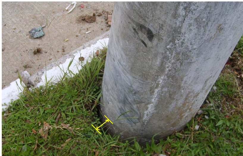
Figura 10. Exemplo de deslocamento da base do poste na altura do engaste.
