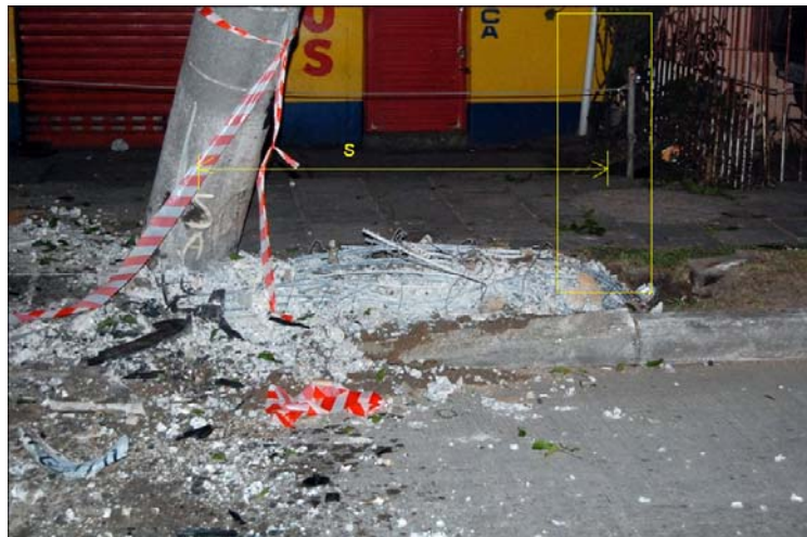
Figura 11. Exemplo de deslocamento de poste em fase 3 ou 4.
