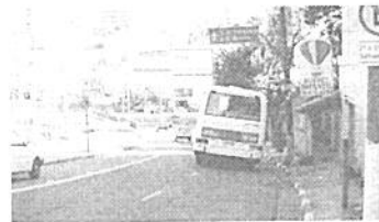
Saída pela tangente: elevação errada em curva da avenida Heitor Penteado.
