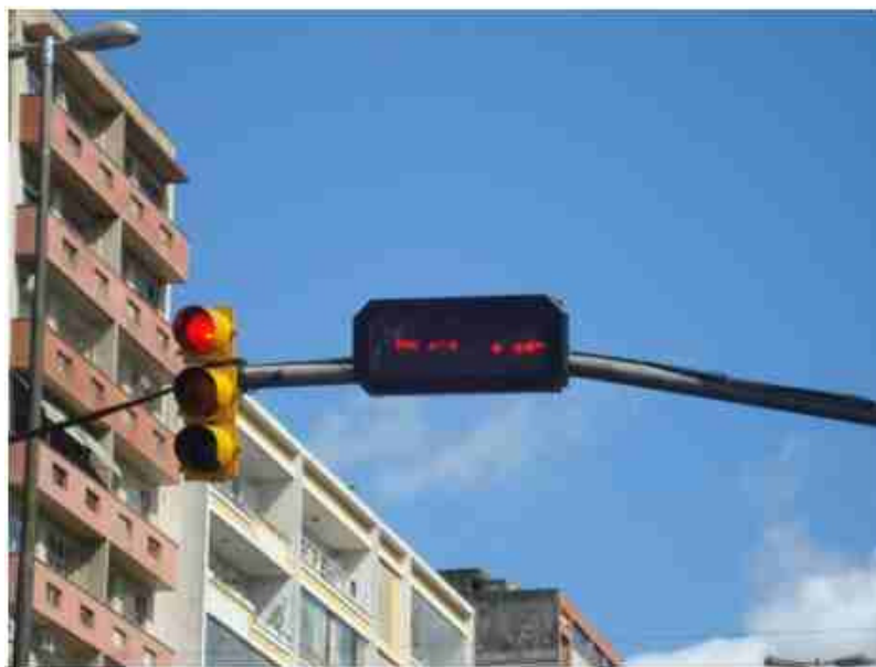
Figura 7: painel de mensagem variável fixado junto ao semáforo.
