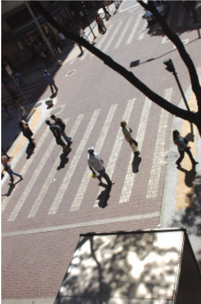
Foto 17 - Faixa Elevada - Travessia em Nível
