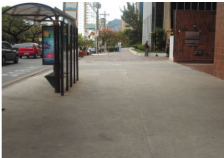
Foto 4 - Calçada com material adequado - regular, contínuo, sem ressaltos ou depressão, firme, estável e antiderrapante.
