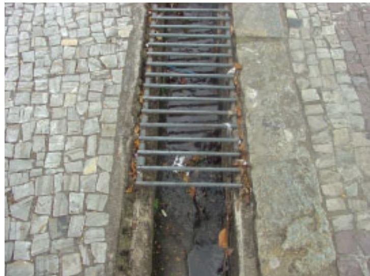
Foto 8 - Grelha no piso, mal dimensionada, podendo provocar o travamento de cadeira de rodas e de bengalas.
