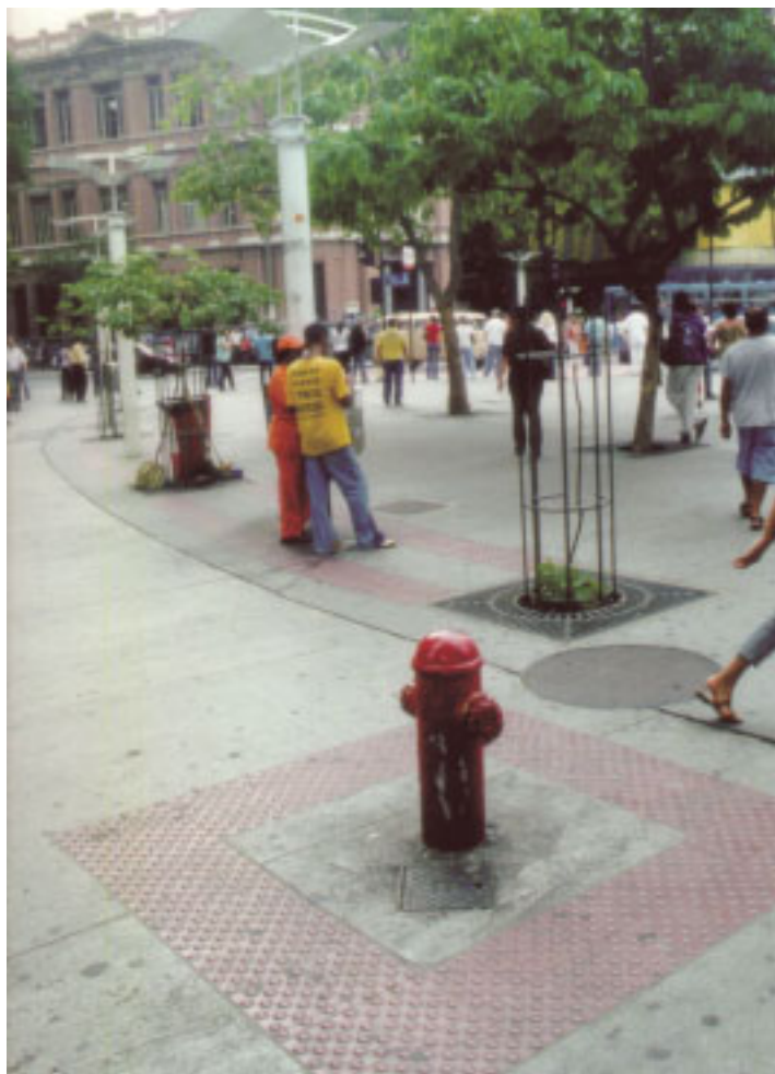
Foto 3 - Hidrante Sinalizado com Piso Tátil de Alerta
