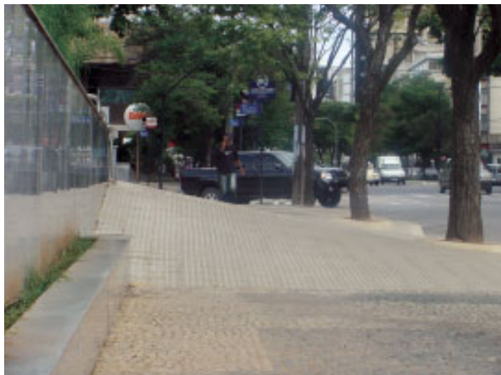
Foto 9 - Calçada com inclinação acentuada, dificultando a locomoção.
