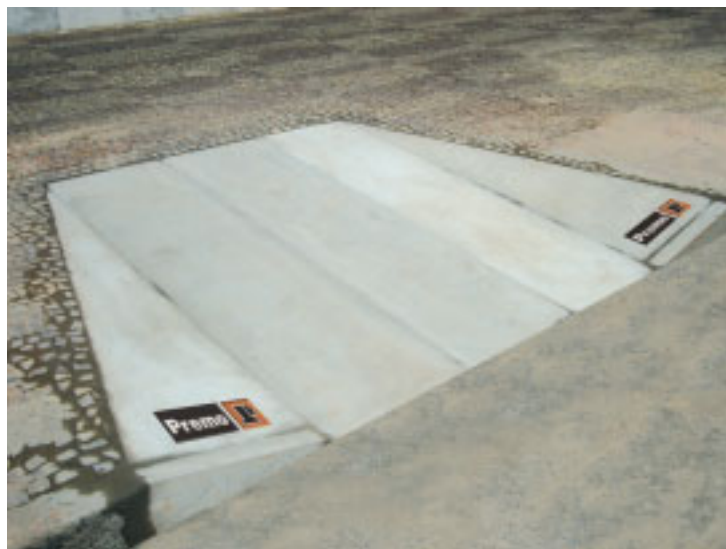
Foto A - Guia rebaixada para vaga reservada de estacionamento
