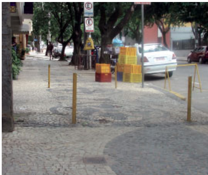
Foto 19 - Postes Metálicos e Balizadores
