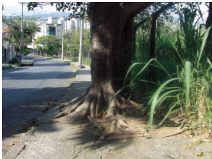
Foto 16 - Raízes de árvores danificando a calçada.
