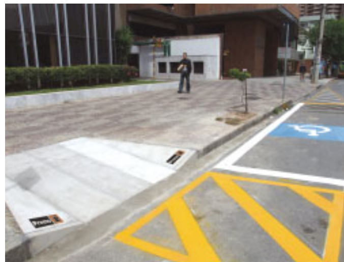
Foto 29 - Vaga Reservada de Estacionamento devidamente sinalizada e com rampa de acesso à calçada.
