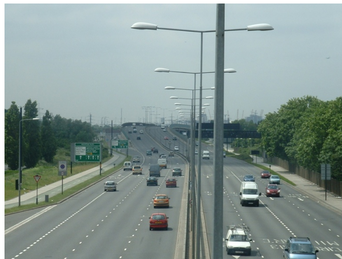
Foto 6: Via A13, junto à saída para Beckton. (Fonte: TfL, 2011)
