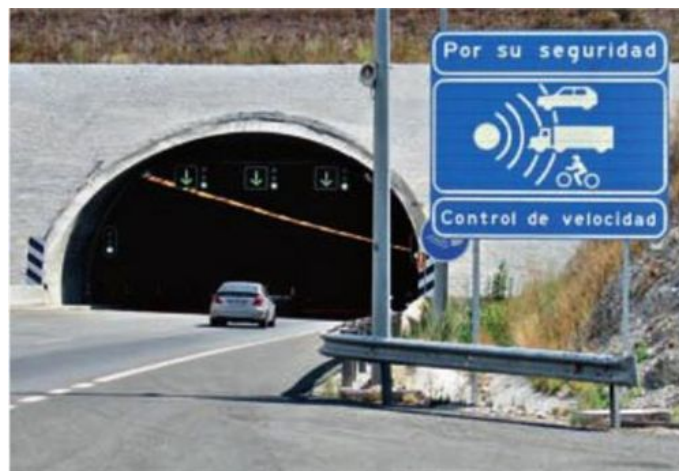
Foto 3: Entrada do túnel de Torrox (Málaga – Espanha), com a sinalização para fiscalização de velocidade (Fonte: EUROPA PRESS, 2011).
