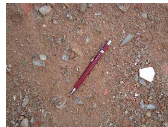
Figura 6: Agregado reciclado compactado na camada de base
