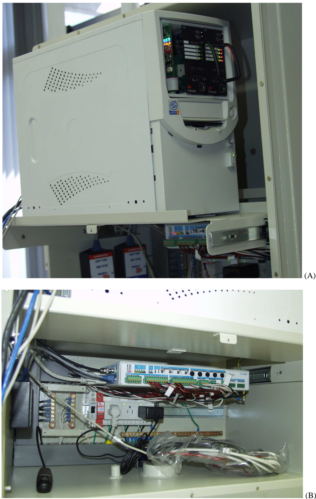
Figura 4-7: Detalhes da montagem do protótipo registrador de veículos. (A) CPU, rack com detectores e placa de monitoração e controle (MCB); (B) Detalhes de montagem abaixo da bandeja da CPU: à direita embaixo: barramento de terra e trilho DIN com disjuntor, proteções, tomadas e filtros; à esquerda, barramentos de distribuição AC protegidos por tampa acrílica; acima o painel de conexões e sinalização (CSP).
