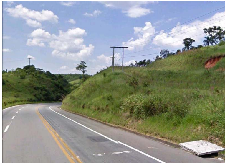
Figura 4-7 - Postes sobre cortes altos não foram considerados como obstáculos potenciais (foto: Google Earth , abril de 2011)
