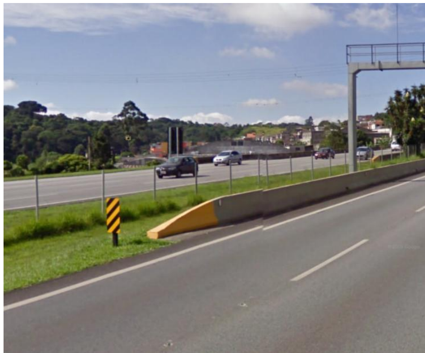
Figura 2-19 - Barreira de concreto com terminal abatido (fonte: Google Earth, Rodovia dos Imigrantes, acessado em mar/2011)
