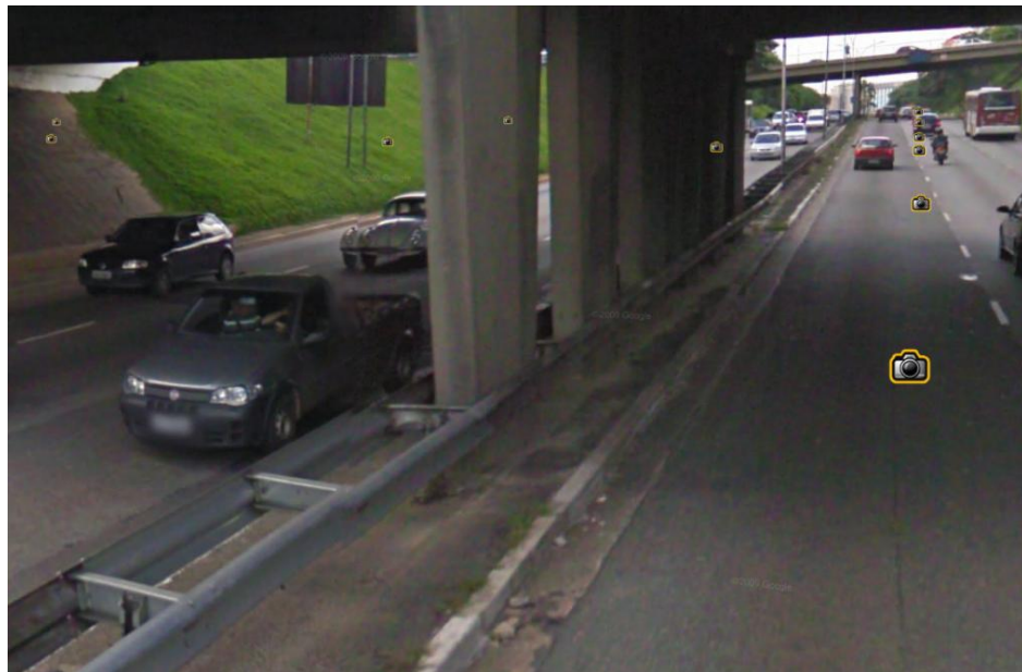
Figura 2-12 - Sistema flexível instalado próximo ao obstáculo. Nota-se que se a defesa fosse instalada alinhada a guia e se a rigidez fosse aumentada localmente, o sistema poderia ser aceitável (foto: Google Earth, Av. 23 de maio, acessado em 09/01/2011)
