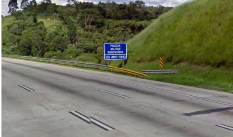
Figura 2-18 - Defesa metálica com terminal abatido. Nota-se que neste caso houve oportunidade para a ancoragem no talude de corte precedente (fonte: Google Earth, Rodoanel de São Paulo, trecho oeste, acessado em mar/2011)
