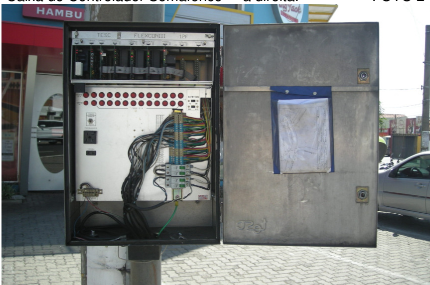
Em campo, sem o programador conectado, não é possível alteração semafórica. FOTO 3
