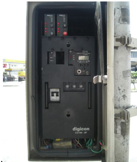
Controlador Semafórico - FOTO 2
